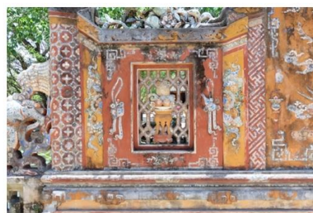
Hình 8 Các điêu khắc trang trí được thực hiện bằng kỹ thuật khảm mảnh sành sứ trên Bình phong ngoại án ở Cung Trường Sanh.
