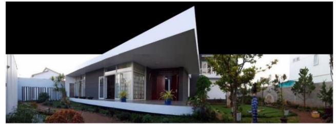
Hình 9 Một góc hiên của công trình thực tế với mái hiên vươn xa và không cần cột đỡ
